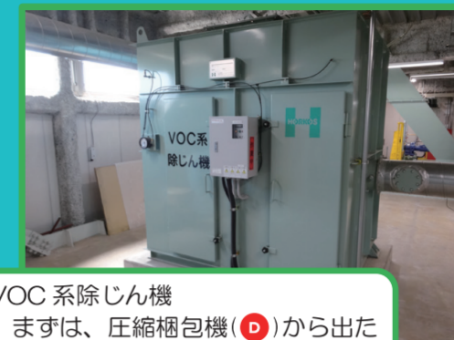
VOC除去装置 次に、VOCを除去装置の光触媒で分解し、キレイな空気に。
